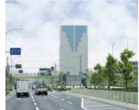
高速道路の地下トンネル換気所 Underground tunnel ventilation facilities on expressways
