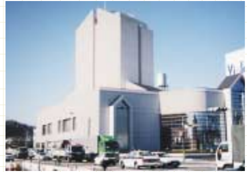
首都高並木トンネルの換気所
