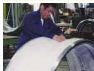
グラスウールをアルミ材に沿って貼る
