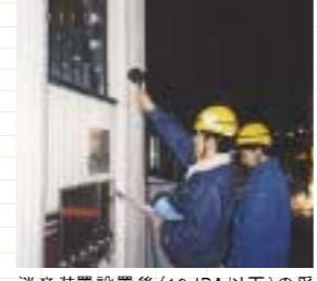
消音装置設置後(40dB以下)の受音点における騒音測定
