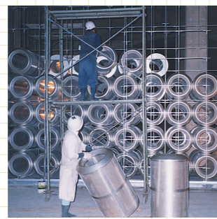
従来の格子を使った施工 丸形エレメントは、格子を組み上げて 施工していた。
