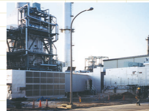
●ガスタービン吸気サイレンサ1号機 国内初のアルミ製吸音スプリッタを採用したガスタービン吸気サイレンサ。
