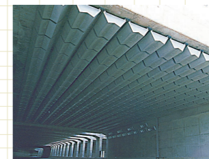
●W形吸音パネル トンネル坑口から伝搬する騒音を効果的に消音。吸音面をW形にすることで、設置面積の1.6倍の吸音面積を確保。
