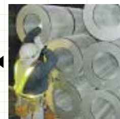
奥側のエレメントを 一人の作業員で積み上げる。
