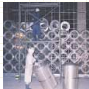
従来の格子を使った施工 丸形エレメントは、格子を組み上げて 施工していた。
