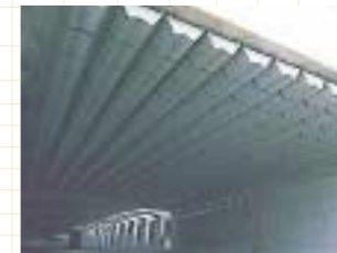
●W形吸音パネル トンネル坑口から伝播する騒音を効果的に消音。吸音面をW形にすることで、設置面積の1.6倍の吸音面積を確保。
