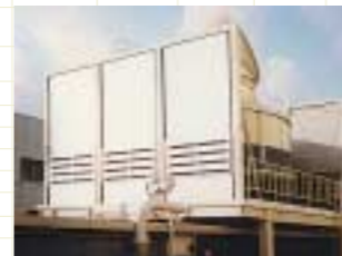
●消音ルーバー クーリングタワーや空調設備の空気取入口からの騒音を消音するルーバー。
