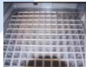
●角形消音エレメント シンプルなピン構造でエレメント同士をつなぎ、高い施工品質と消音性能を実現している角形消音エレメント。
