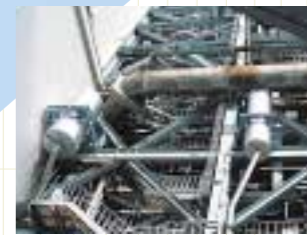
●ボイラ蒸気安全弁サイレンサ 火力発電所などのボイラから出る蒸気が大気放出時に発する騒音を消音するサイレンサ。
