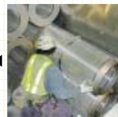
前後のエレメントも 連結金具によって正確に接合できる。
