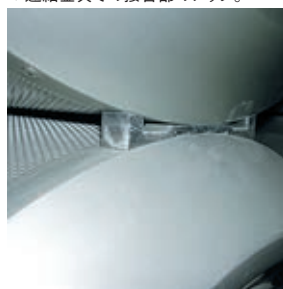
▼連結金具での接合部のアップ。
